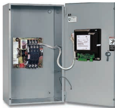
Fig. 2: Conmutador de transferencia de alimentación ASCO de 200 amperios
